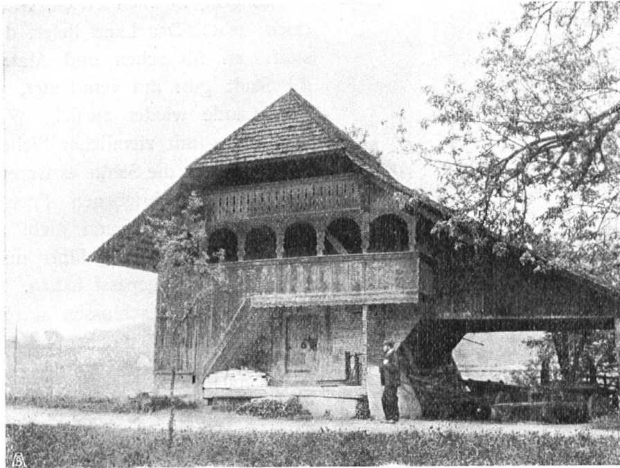
Abb. 9. Speicher in Sumiswald. Aufnahme von Architekt Bruno Padel , Bern. Fig. 9. Grenier à Sumiswald.
