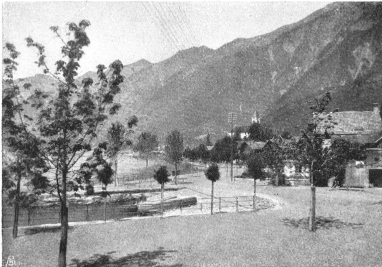
Abb. 33. Der neu angelegte Quai in Brienz. Die Mauer folgt der Uferlinie und gibt dem Wasser an jeder geeigneten Stelle Zutritt. Aufnahme von Photogr. Schild-Bichsel, Brienz. — Fig. 33. Les nouveaux quais de Brienz. Les murs suivent les formes de la rive et permettent l'accès du lac à tous les endroits favorables.
