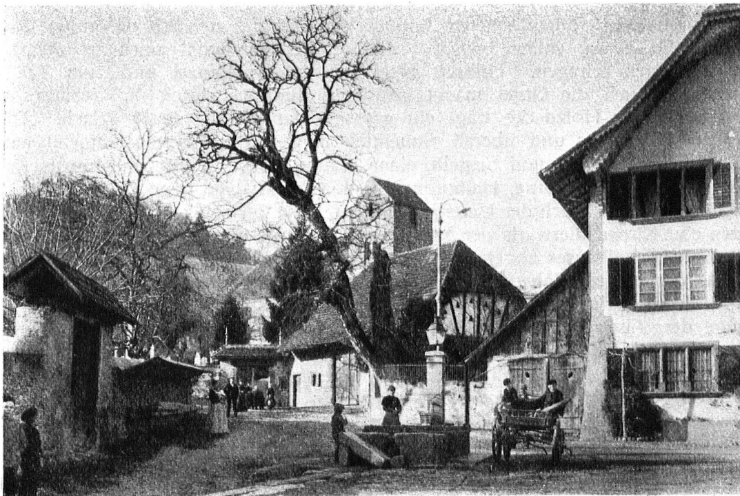
Abb. 10. Baugruppe bei der Kirche von Erlach. — Von links nach rechts: Einfriedung der Pfarrmatte und Kirchhofeingang, Pfarscheune und Pfarrhaus. Aufnahme von Dr. E. Blank. — Fig. 10. Groupe de maisons et église de Cerlier. De gauche à droite: Mur d'enceinte du préau de la cure; entrée du cimetière, grenier de la cure, et la cure elle-même.
