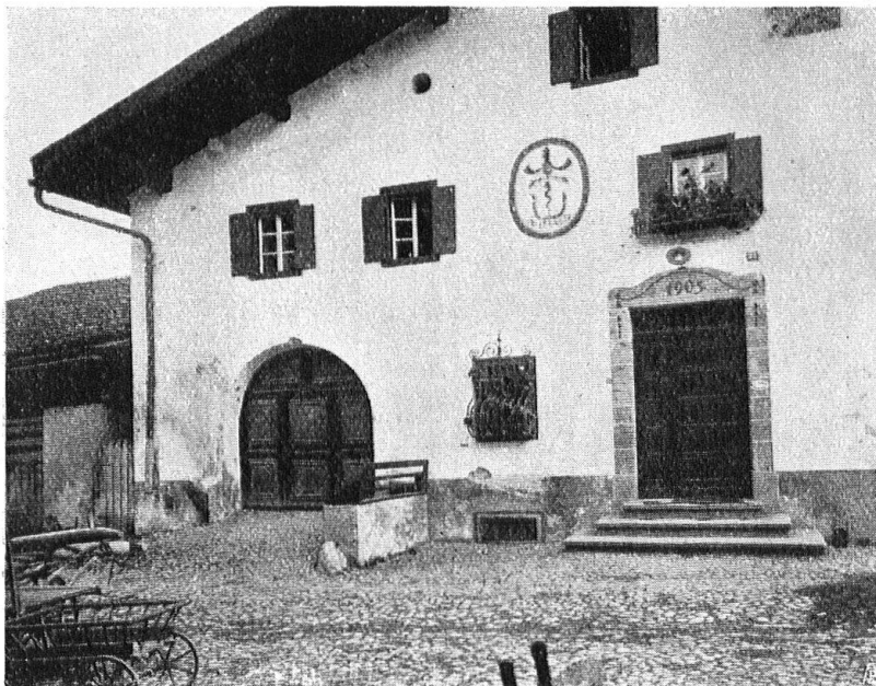
Abb. 16. Haus von Oberstleutnant Schmidt. 1903 umgebaut von Architekt B. S. A. Nikolaus Hartmann in St. Moritz. — Fig. 16. Maison de M. Schmidt, lieutenant-colonel. Transformée et restaurée en 1903 par M. Nic. Hartmann, architecte à St. Moritz.
