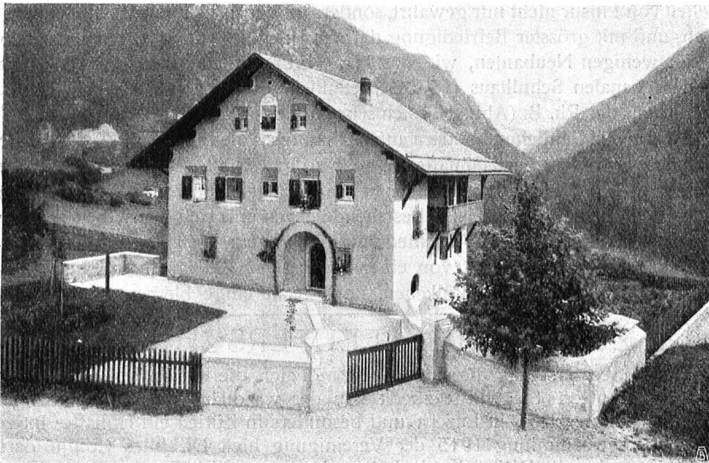
Abb. 18. Bahningenieur-Haus der Rhätischen Bahn; ein, der heimischen Bauweise trefflich angepasster, künstlerisch origineller Bau von Architekt Lorenz der Rh. B. — Fig. 18. Maison de l'ingénieur des chemins de fer Rhétiques. Construction originale et d'un goût artistique dont le style s'accorde parfaitement avec l'architecture indigène. Architecte M. Lorenz.
