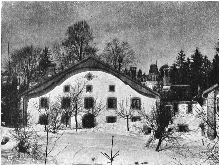
Abb. 16. Gegenbeispiel. Falsche Anwendung der Giebelverschalung des Bernerhauses auf das flache keltoromanische Haus. Eines der letzten jurassischen Bauernhäuser in La Chaux-de-Fonds. — Fig. 16. Mauvais exemple. Application fautive du pignon de la maison bernoise à un bâtiment celtoroman. Une des dernières constructions rustiques de La Chaux-de-Fonds.
