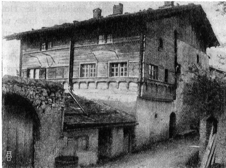
Abb. 1. Alpenhaus; aus Holz und Stein. Altes Rathaus in Malans. Aufnahme von Architekt Rudolf Gaberel, Davos. — Fig. 1. Chalet alpestre. Construction en bois et en pierre.
