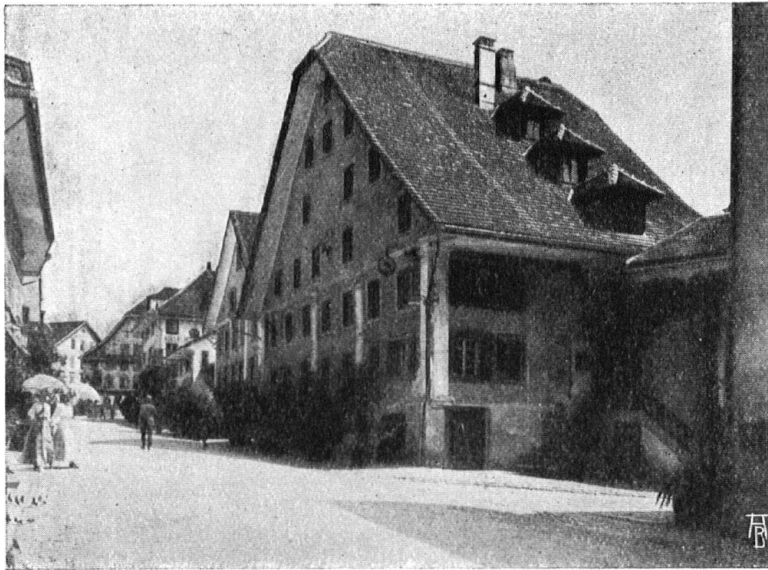
Abb. 13. Alter Gasthof in Küsnacht am Vierwaldstättersee. Mit Giebelausbildung nach bäuerlicher Bauart; die Überstände sind, wie im Appenzellerhaus, verputzt. Aufnahme von Architekt Krebs, Luzern. — Fig. 13. Ancien hôtel à Küsnacht, lac des Quatre-Cantons. Ici, comme en Appenzell, la partie de la façade encadrée par le toit est encore protégée par des clavins.
