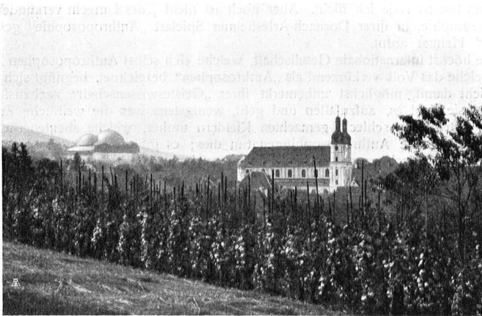
Abb. 14. Domkirche und „Johannesbau“. Gutes und schlechtes Beispiel: Gediegene, massvolle Baukunst und effekthaschende Dilettantenarchitektur — leider auf einem Bilde in einer Landschaft! Aufnahme von J. Grieder, Arlesheim. — Fig. 14. La cathédrale et le „Temple“ des anthroposophes. Parallèle d'une bonne et d'une mauvaise architecture: l'une simple et d'un goût excellent, l'autre énorme, prétentieux, et cela, malheureusement, dans le même paysage.
