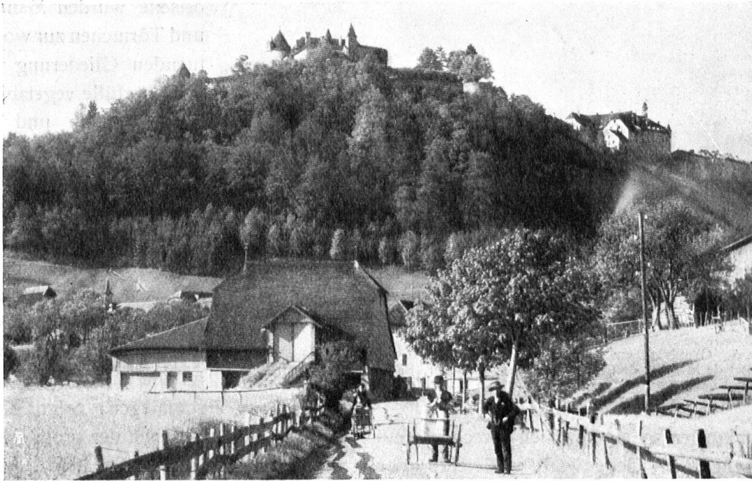
Fig. 3. Le château et la ville, vus d'Epagny. Cliché Jullien frères, Genève. Abb. 3. Blick auf Schloss und Stadt, von Epagny aus.
