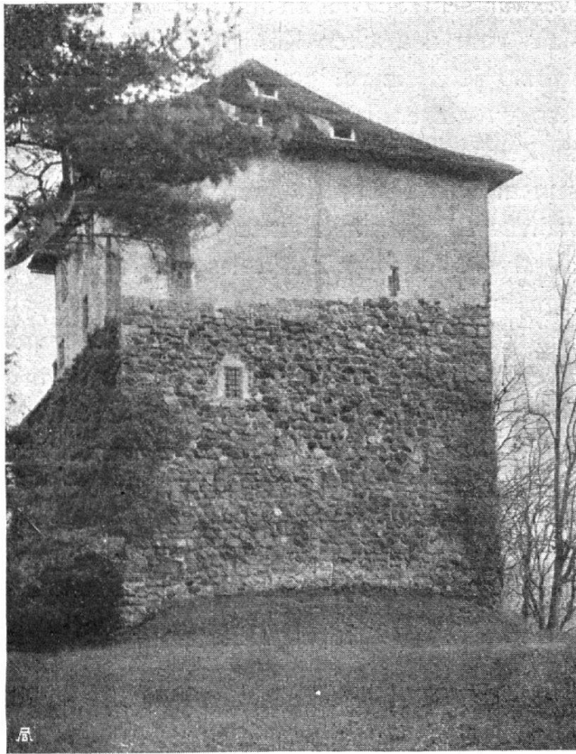
Abb. 2. Schloss Mörzburg. Nordseite, auf der das gewaltige Mauerwerk zum Teil freiliegt. Aufnahme (wie Abb. 3) von H. Linck, Winterthur, für die Antiquarische Gesellschaft, Zürich – Fig. 2. Château de Mörzburg. Façade nord, où les imposantes murailles se montrent dans toute leur amplitude. Photographie (ainsi que n° 3) prise par H. Linck pour la Société d'archéologie, de Zurich.
