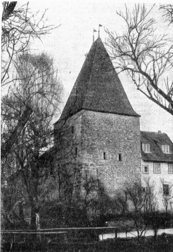
Abb. 13. Alter Turm in Wiedlisbach. Das im ganzen wohlhaltene, in Einzelheiten unlängst glücklich renovierte Wahrzeichen des Ortes. — Fig. 13. Vieille tour à Wiedlisbach, restaurée avec goût il y a quelque temps, et qui donne à la petite ville son cachet particulier.
