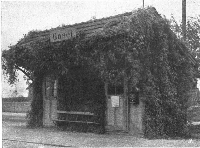
Abb. 3. Station Gasel (an der Linie Bern-Schwarzenburg). Primitivster Bau, von Waldreben umschlungen. Aufnahme von Max Schio, Hochbautechniker in Burgdorf. — Fig. 3. Halte de Gasel sur la ligne Berne-Schwarzenbourg. Petit bâtiment des plus primitifs tout embelli de climatis.
