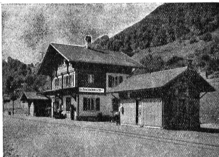
Station der Brienzerseebahn. Eternit-Doppeldach, kupferbraun
