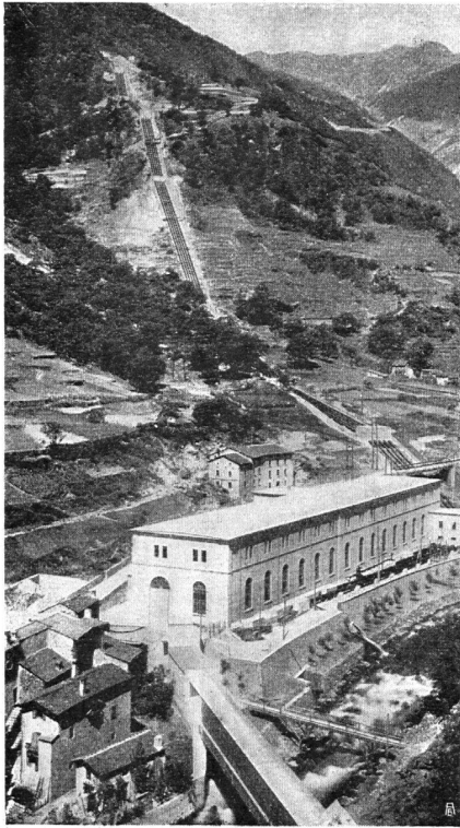
Abb. 10. Gegenvorschlag. Durch Pflanzung von zwei Baumreihen beidseitig der Druckleitung kann der Eindruck einer mächtigen Allee erweckt werden. Zu beachten der Verbesserungsvorschlag für das flache Dach des Maschinenhauses. — Fig. 10. Projet de correction: En plantant des deux côtés de la conduite hydraulique deux rangées d'arbres, on peut donner l'illusion d'une grande allée. Remarquer aussi la correction proposée du toit de la halle aux machines.
