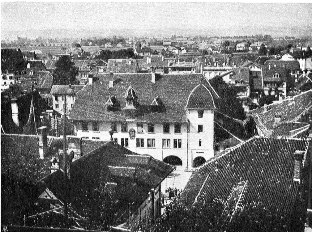
Abb. 13. Thun. Blick über die Dächer. Vorn rechts: alte Hohlziegeldeckung. Aufnahme von A. Ramseyer. — Fig. 13. Thoune. Vue sur les toits. Au premier plan, à droite, toits de tuiles anciennes. Cliché A. Ramseyer.
