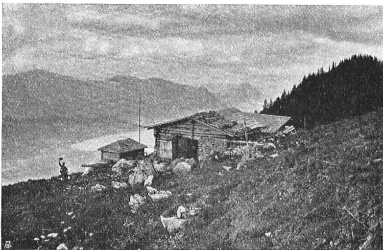
Abb. 3. Alphütte auf Stanserhorn. Schindelschwerdach und Schindelnageldach. — Fig. 3. Chalet sur une alpe du Stanserhorn. Toit de bardeaux, en partie cloués, en partie consolidés par des pierres.
