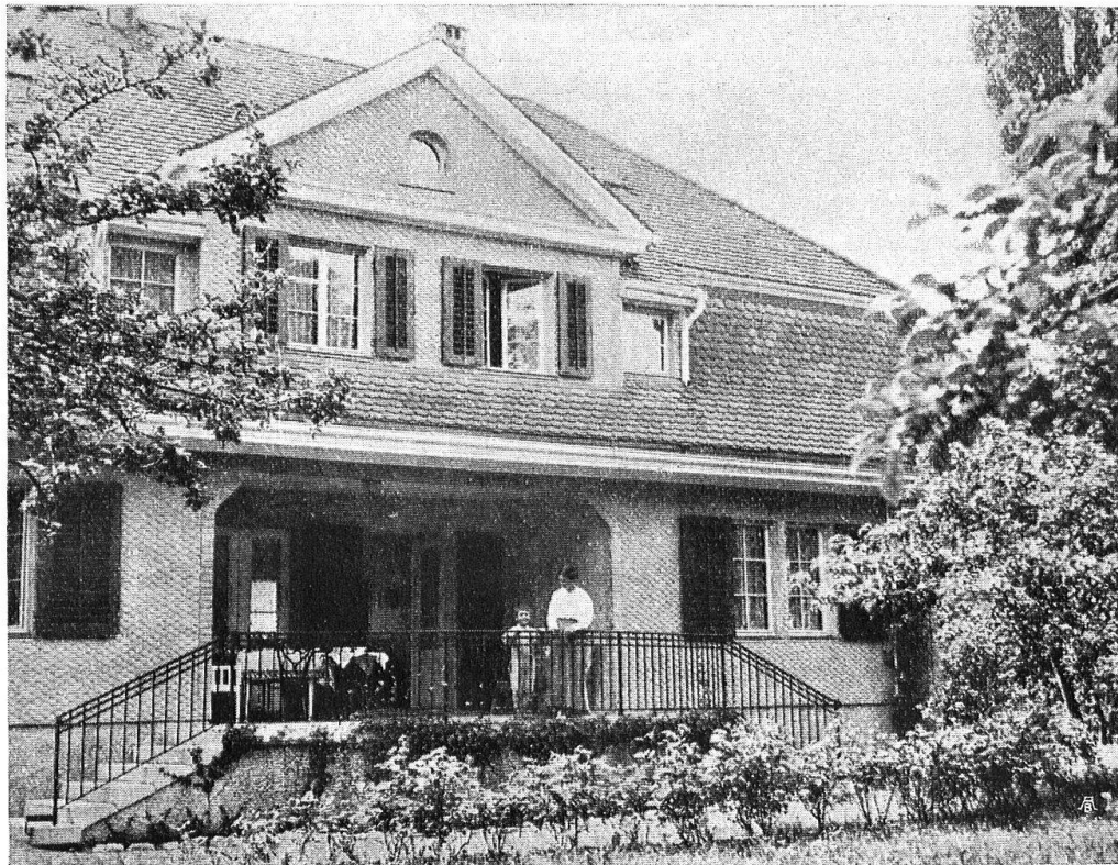
Abb. 25. Villa. Architekten Streiff & Schindler, Zürich. Äussere Wandverkleidung: Eternit in Wabendeckung; Dach: Bieberschwanz-Ziegel. — Fig. 25. Villa Streiff & Schindler, architectes, Zurich. Revêtement extérieur des murailles en éternite. Toit de tuiles.
