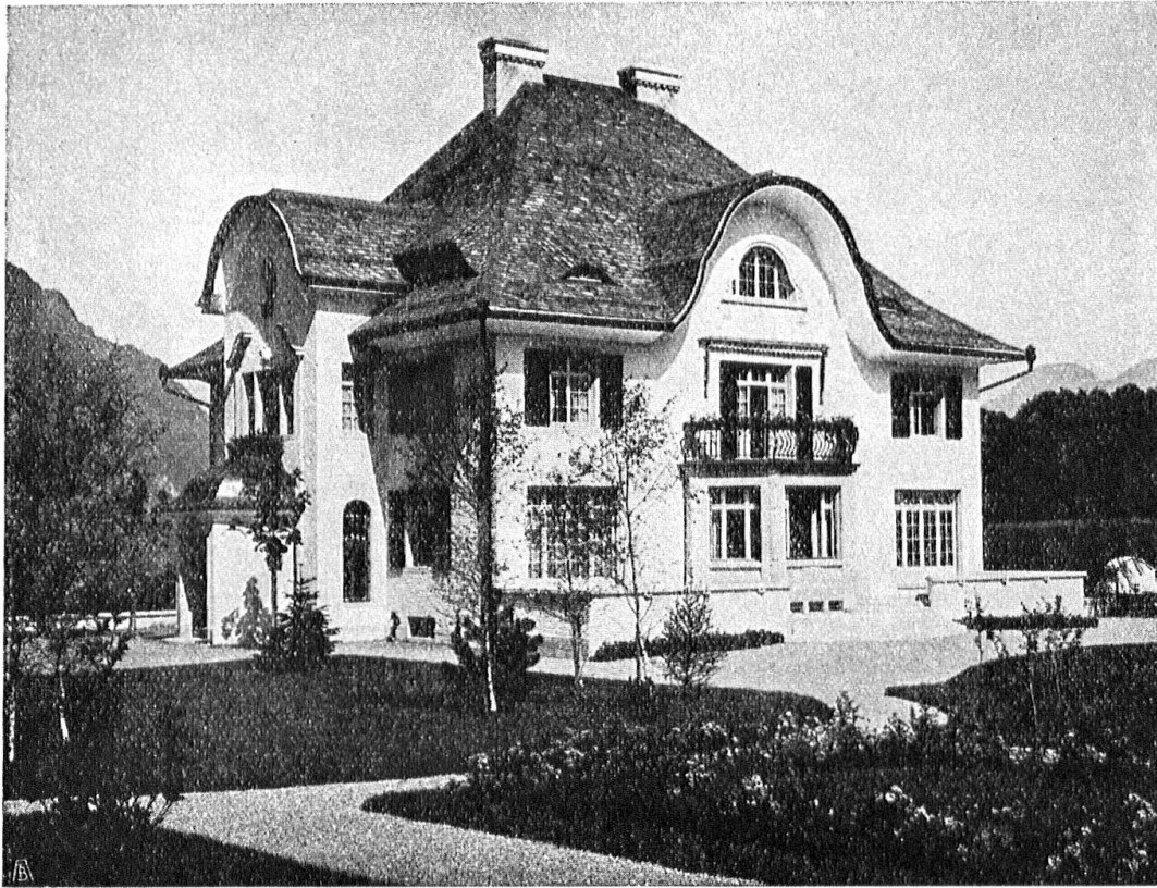
Abb. 24. Villa in Glarus. Architekten Streiff & Schindler, Zürich. Gute Bedachung in Eternit; rotbraune schmale Platten in horizontaler Schichtung. Bemerkenswerte Lösung! — Fig. 24. Villa, dans le canton de Glaris. Streiff & Schindler, architectes, Zurich. Toit d'éternite. Petites plaques d'un rouge brun, rangées horizontalement. Solution remarquable.
