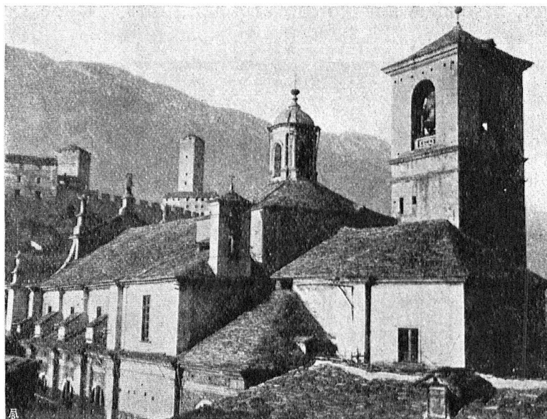
Abb. 1. Steinplattendach in Bellinzona. Aufnahme von A. Ramseyer. Fig. 1. Toit de pierres plates, à Bellinzone. Cliché A. Ramseyer.
