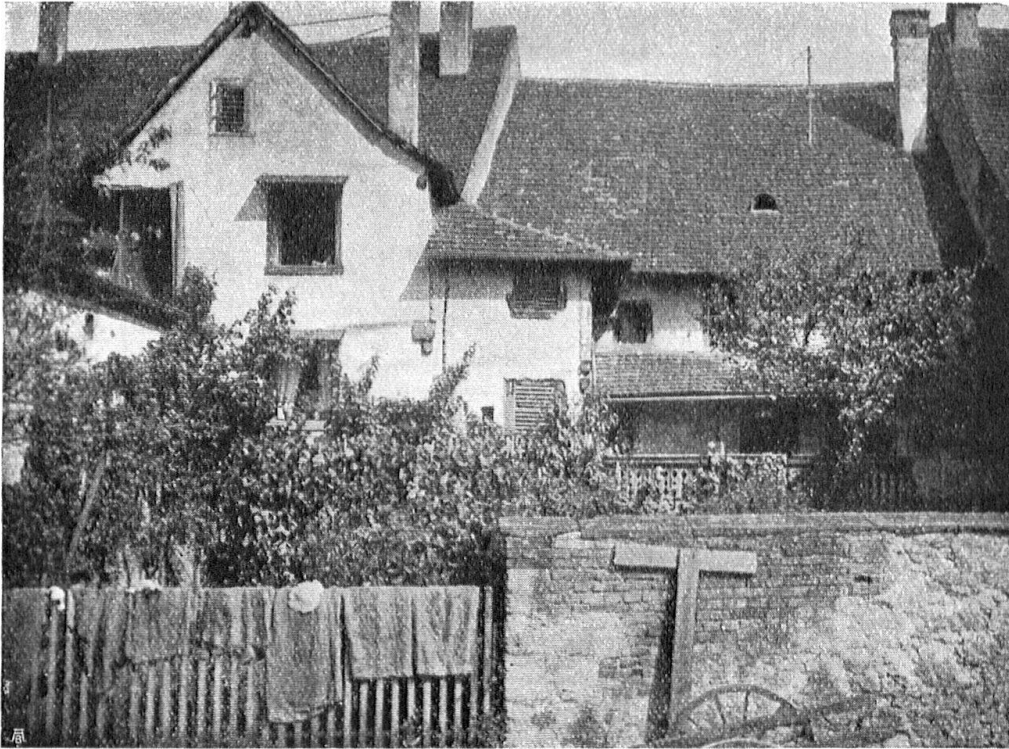
Abb. 12. Zurzach. Dächer mit einfacher Ziegeldeckung. Aufnahme von K. Ramseyer. Fig. 12. Zurzach. Toits revêtus de tuiles ordinaires. Cliché K. Ramseyer.
