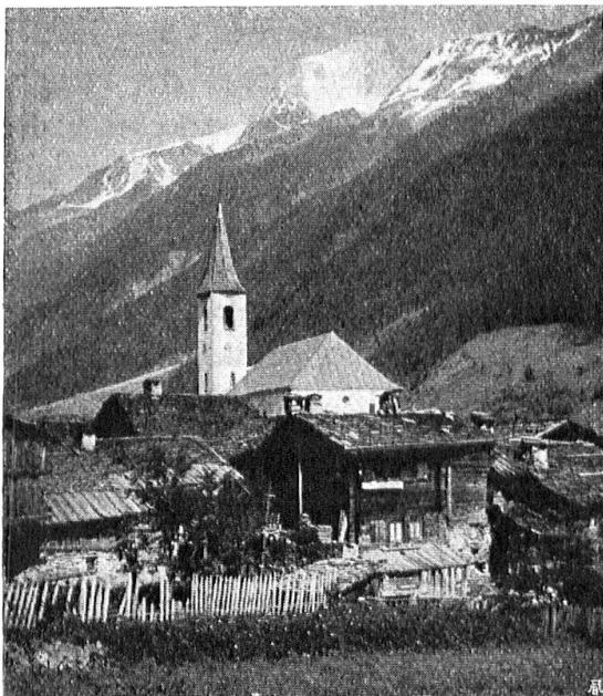
Abb. 21. Kippel im Lötschental. Das Blechdach der Kirche passt schlecht zum Dorfbild. Aufnahme von H. Gattiker in Gümligen. — Fig. 21. Kippel, dans le Lötschenthal. La toiture de fer-blanc du clocher détonne désagréablement au milieu de ce village alpestre. Cliché H. Gattiker à Gümligen.
