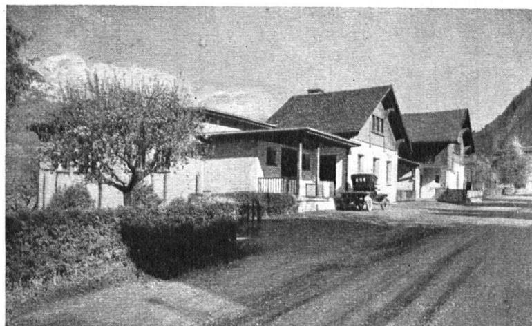
Abb. 10. Zwirnerei Iten in Flüelen: Magazin, Bureau und Fabrikgebäude, in Gruppen aufgelöst. Dem Landschaftsbild gut eingefügt. — Fig. 10. La retorderie Iten à Flüelen: magasins, bureau et ateliers bien distribués par groupes de bâtiments. En accord avec le paysage ambiant.
