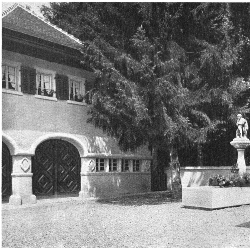
Abb. 9. Garage Arthur Frölich in Bergdietikon. Technischer Bau mit Wohnung verbunden. Gute Türen. Architekt Albert Frölich, Zürich. — Fig. 9. Garage Arthur Frölich à Bergdietikon. Bâtiment d'exploitation industrielle, avec appartement. Portes d'un beau modèle. Albert Frölich, architecte, Zurich.
