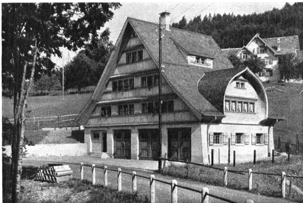
Abb. 16. Garage in Schachen, mit Raum für drei Lastautos der Holzhandlung J. U. Stüdi. Ueber der Garage Angestelltenwohnungen der Firma. Die Täfer und Gesimse der Strassenfront wie die ganze Bauform entsprechen in vorbildlicher Weise den umliegenden Höfen im Toggenburger Charakter. Architekt E. Hunziker, Degersheim. — Fig. 16. Garage à Schachen pour trois autocamions de la maison J. U. Stüdi, commerce de bois. Au-dessus du garage les appartements des employés de la maison. La façade en colombage, ses auvents et toutes les formes essentielles du bâtiment sont inspirées de l'architecture indigène et en parfaite harmonie avec les fermes environnantes du Toggenbourg.
