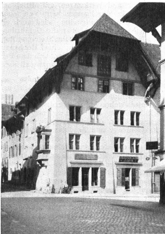
Abb. 20. Das Weibezahlhaus in Aarau, vor dem Umbau. Charakteristisch der Mittelpfeiler, zwischen den später entstandenen Magazinen der Hauptfront. Fig. 20. Le Weibezahlhaus à Aarau avant la restauration. Remarquer le contrefort qui sépare les deux magasins de la façade principale.
