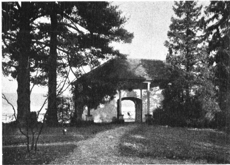
Abb. 6. Schloss Wädenswil. Eingang zum innern Garten, als gedeckte Aussichtshalle ausgebildet, gegen See und Alpen geöffnet. Rückseite mit über den Weg vorspringendem Dach, von schlanken Säulen getragen. Photographie: Kantonales Hochbauamt, Zürich. — Fig. 6. Château de Wädenswil. Entrée du jardin intérieur. Ce portail en forme de pavillon, ou de belvédère, est ouvert du côté du lac et des Alpes. La façade, côté jardin, est agrémentée d'un toit supporté par de légères colonnes. Cliché du Bureau cantonal d'architecture, Zurich.
