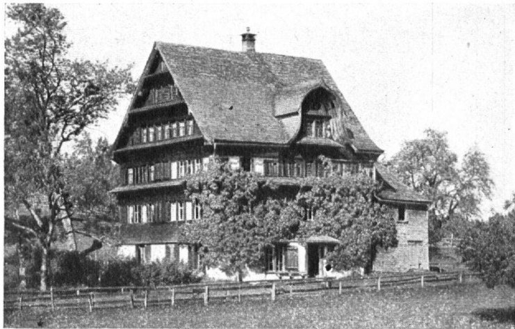
Abb. 4. Niederhauen-Nesslau. Geschweiffter Querhausgiebel, Eingang im gemauerten Erdgeschoss. (Aufnahme von Photoglob-Zürich.) — Fig. 4 Niederhauen-Nesslau. Un pignon à formes sinueuses sur le côté; entrée dans le rez-de-chaussée en maçonnerie. (Cliché du Photoglob, Zurich.)
