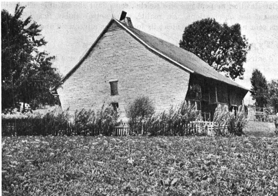
Fig. 1. Autigny : 1730. Ramire pentagonale en tavillons à l'ouest avec de rares ouvertures surmontées de renvoi d'eau. La fenêtre supérieure est récente. Toit réveillonné, où l'on voit l'ancienne borne avec son couvercle à bascule. — Fünfeckige Schindelwand auf der Wetterseite, fast fensterlos, das obere Fenster später ausgebrochen. Bretterkamin mit Klappdeckel.
