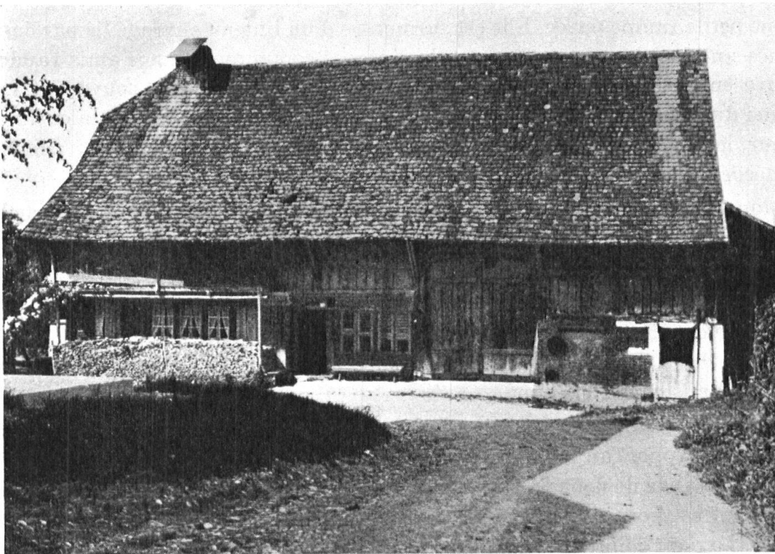
Fig. 5. Cousset : 1811. Ferme de la Broye en bois. Disposition broyarde: habitation, aire, étable. — Holzhaus in Cousset, Broyebezirk. Broyerische Anordnung: Wohnbau, Tenne, Stall.
