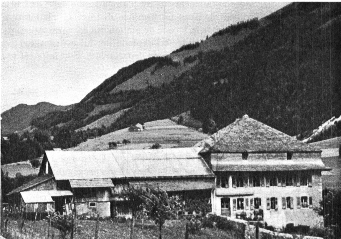
Fig. 3. Les Bellegardes, Montbovon : 1753, 1789. Toit à la Mansard sur l'habitation seule, donnant à ce corps de bâtiment une allure bourgeoise, accentuée encore par le nombre et la disposition des fenêtres. — Das Wohnhaus in Bubenberg (Greyerz) mit Mansardendach hat ein bürgerliches Aussehen, das durch die Zahl und die Anordnung der Fenster noch verstärkt wird.
