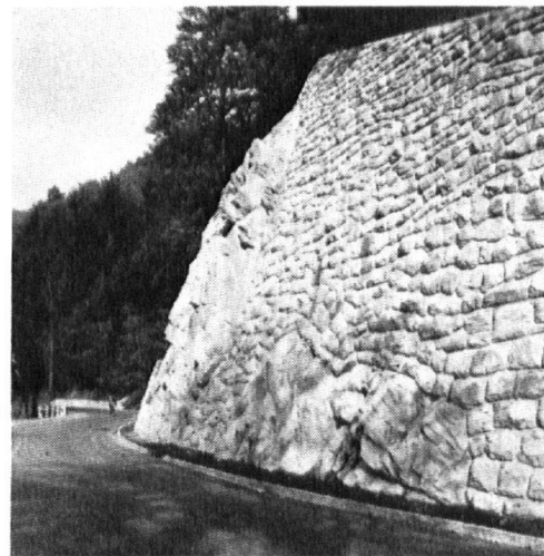
8. Wildes, unregelmässiges Mauerwerk aus Nagelfluh in wildem Felsen. (Strasse Walchwil-Arth, Kt. Schwyz.)
