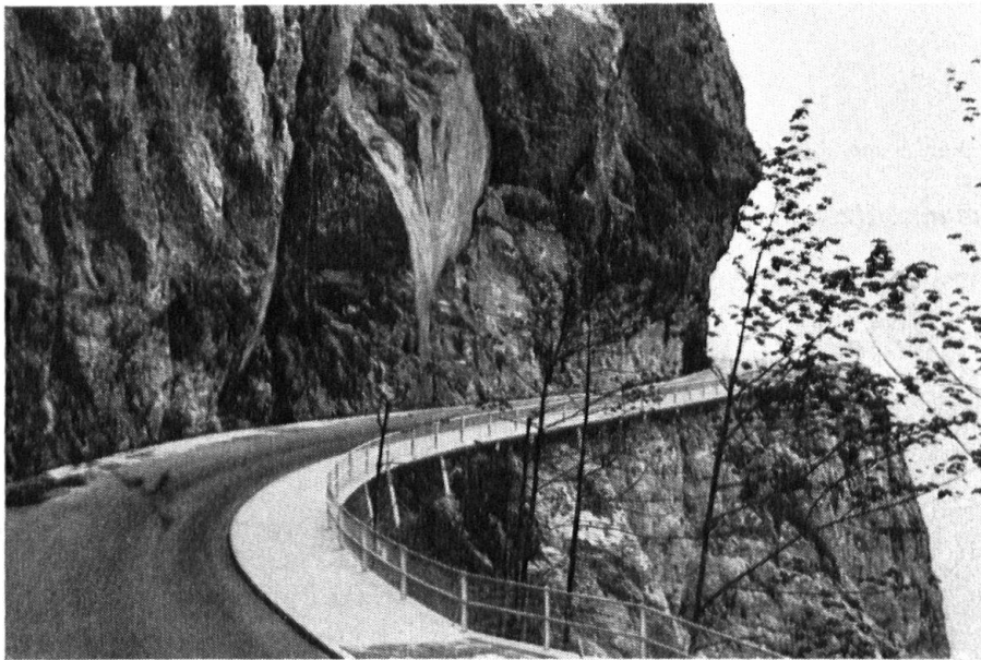
33. Halbgalerie. (Obere Vitznauerstrasse, Kt. Luzern, 1935.) — Galerie ouverte.
