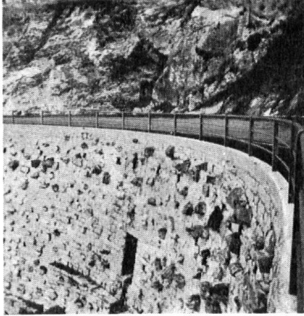
10. Naturverbundene Ansichtsflächen von Bruchsteinmauern mit vorstehenden Spitzbossen. (Axenstrasse.)
