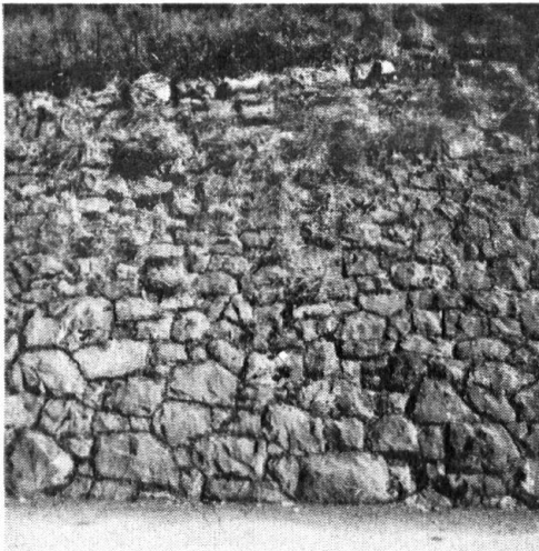
15. Altes, unregelmässiges Trockenmauerwerk. (Axenstrasse.)
