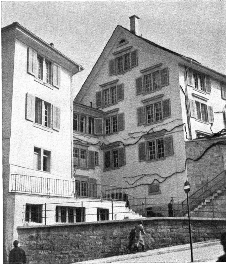
Zugang zum Heimethus von der Rückseite. Das typische Zürichhaus vor etwa 1800. Früher Pestalozzianum.
