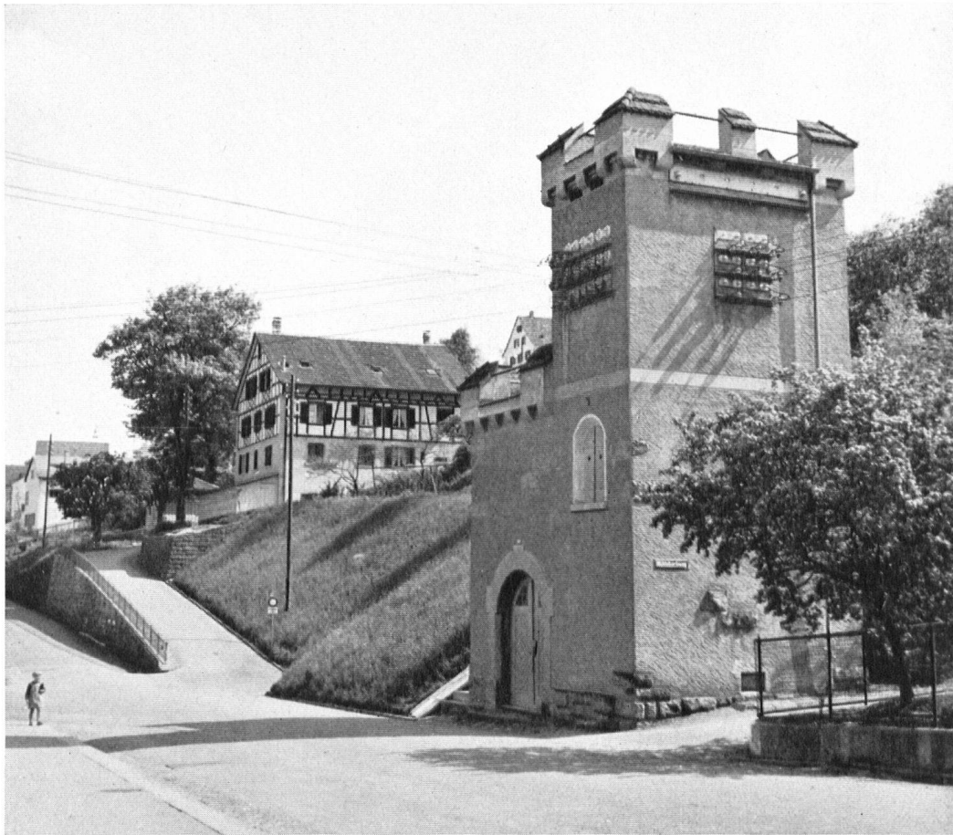
Endlich „Heimatschutz“!! Transformatorenhäuschen in Gestalt einer Ritterburg en miniature! Et enfin, ô merveille des merveilles, un transformateur « moyen-âge »! Avis au Heimatschutz!
