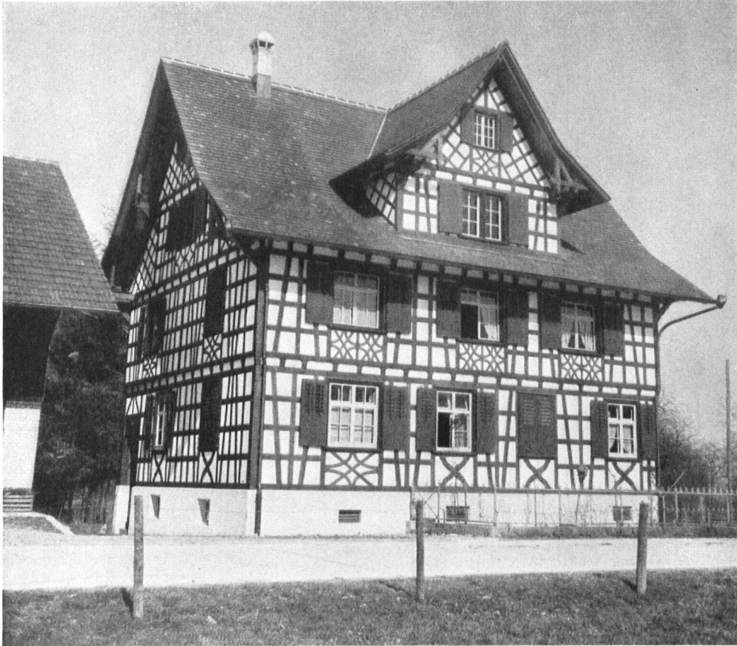
Haus Schönholzer in Stadel-Buch im Egnach. Beispiel eines neuerbauten Thurgauer Riegelhauses. Entièrement neuve, la maison Schönholzer, à Stadel-Buch, sonne le réveil de l'architecture autochtone.
