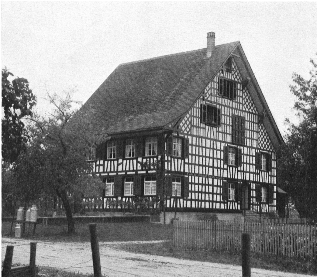
Häberlihaus in Langreut in Egnach, 1689 erbaut. Ein selten reiches und zugleich zierliches Riegelwerk. Auf dem Tragbalken über dem Eingang neuer Hausspruch.
