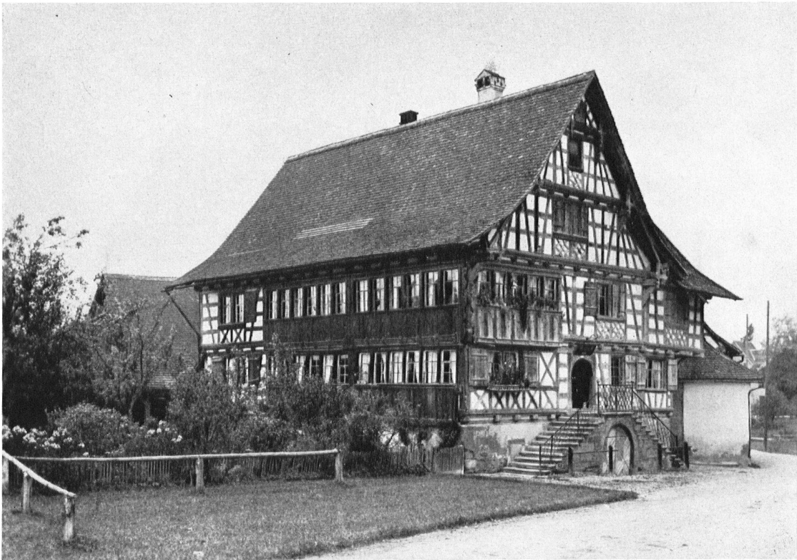
Ehemaliges Gerichtshaus Oberaach (sog. Häberlihaus), 1711 erbaut, vor der Renovation. (Siehe auch Abb. S. 5.)
