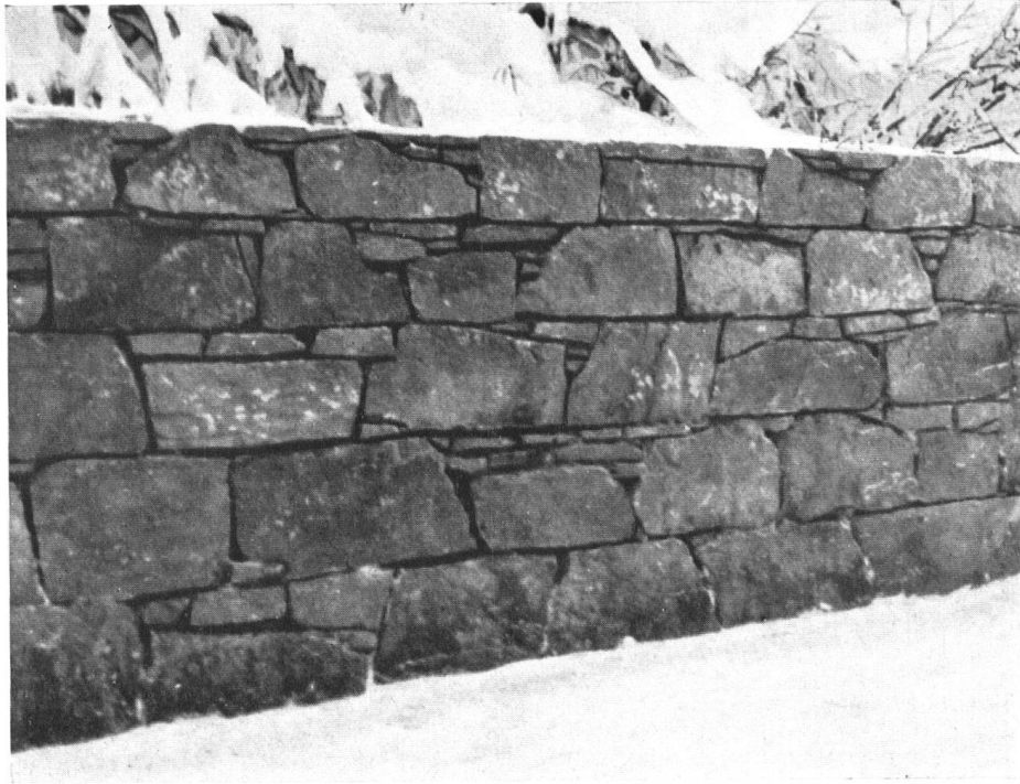
Muster-Mauerwerk, zur Belehrung der Arbeiter „trocken“ aufgesetzt. (Steiermark.) Un mur modèle pour apprendre aux travailleurs le procédé de la pierre sèche. (Steiermark.)
