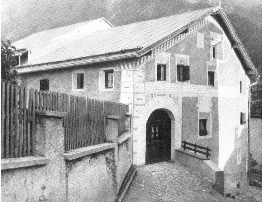
Haus Stuppan in Ardez. Typisches Unterengadiner Bauernhaus. Mit der Zeit wird der Hausbesitzer auch ein besseres Eingangstor machen lassen. Maison Stuppan, à Ardez; habitation paysanne de la Basse Engadine. La Casa Stuppan a Ardez, tipico esempio di casa rurale della Bassa Engadina. Col tempo il proprietario intende rinnovare anche il portone d'ingresso.
