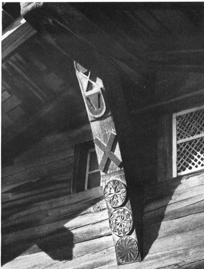
Prachtvoll geschnitzter Stützbalken mit sehr alten sinnbildlichen Motiven am Hause Briw in Ernen. Corbeau, sculpté d'armoiries et de symboles antiques, au faite de la maison Briw, à Ernen. Una trave riccamente intagliata con antichi motivi simbolici sulla casa Briw a Ernen.
