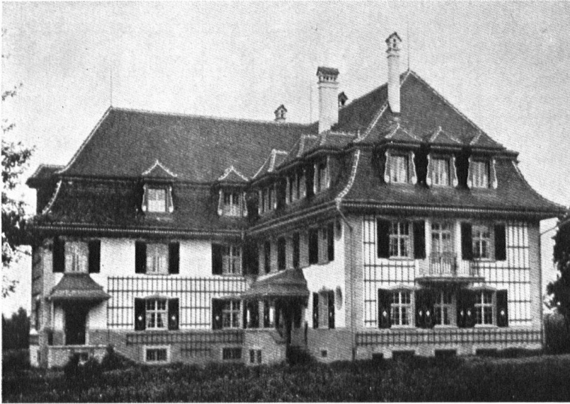
Krankenhaus in Cham. »Beispiel eines in der heimatechten äußeren Gestaltung vorbildlichen Gebäudes«, erbaut 1908–09, Architekten Keiser und Bracher, Zug. Man muß diesen wohnhausartigen Bau im Gegensatz zu den damals üblichen kasernenartigen Krankenhäusern sehen, um zu verstehen, daß die hier erfolgreich angestrebte Intimität einen großen Fortschritt bedeutete. Ein technisch stilisiertes Krankenhaus hätte damals auf die Patienten erschreckend gewirkt (1909).
