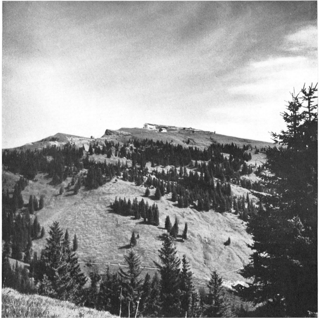
Unauffällig schmiegt sich das neue Kulmhaus an die Gipfelkuppe.
