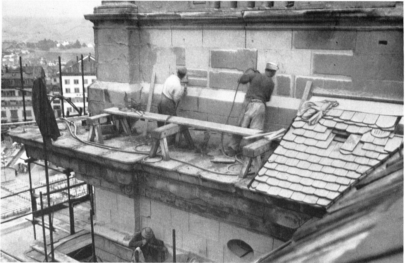
Diese beiden Bilder illustrieren die Verwendung der (Bildbauer-)Preßluft-hämmer. Um sie vor allem entbrannte die Meinungs-verschiedenheit zwischen dem Stift und den eidgenössischen Experten (s. Text). Auf dem obern Bild ist das sog. Scharrieren, d. h. Zurückhauen der Oberfläche der Mauerquadern zu erkennen. Wir verweisen auch dieserhalb auf den erläuternden Text.
