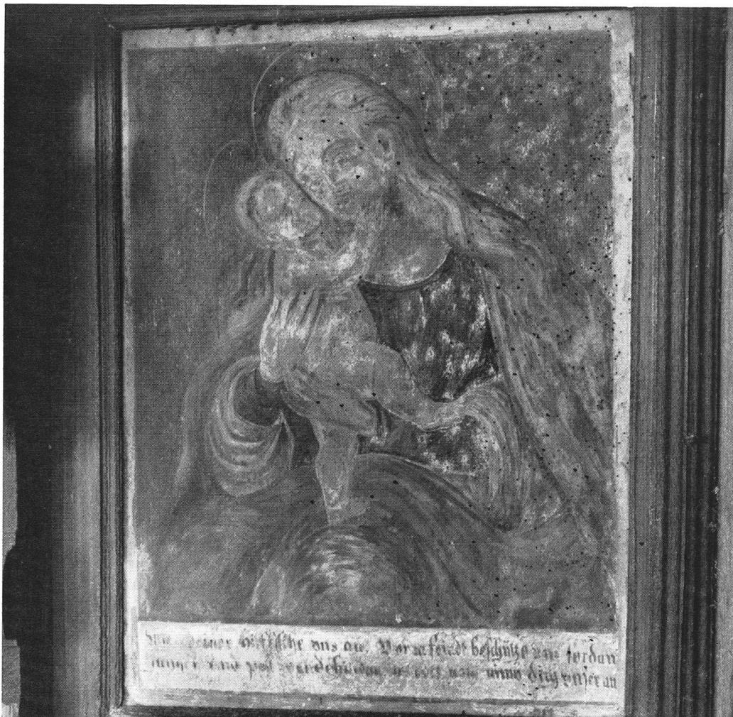
Auch das Muttergottesbild an der Seewand des ‚Hauses zur Treib‘ ist zerwurst und die Farbe blättert ab, auch hier tut eilige Hilfe not, wenn die reizvolle, ländliche Malerei gerettet werden soll. Siehe im übrigen den erläuternden Text von W. Zeller.
