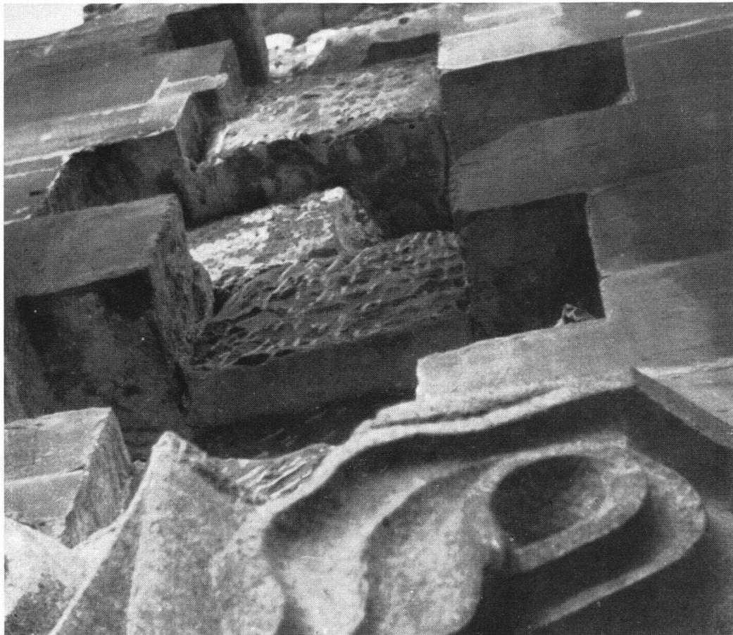
*Die gleiche Partie nach Versetzung der neuen Werkstücke: Krabben, Knauf und Kreuzblume in hartem Molière-Kalkstein, originale Quader in der Mauerfläche in Freiburger Sandstein, die exponierten Teile des Abschlußgesimses im widerstandsfähigern Sandstein aus dem Steinbruch von Guntlisweid bei Bäch am Zürichsee. Unmittelbar daneben bleibt die Oberfläche der alten Quader, die in der Mitte alle noch das Loch der Hebevorrichtung zeigen, unberührt erhalten.*
