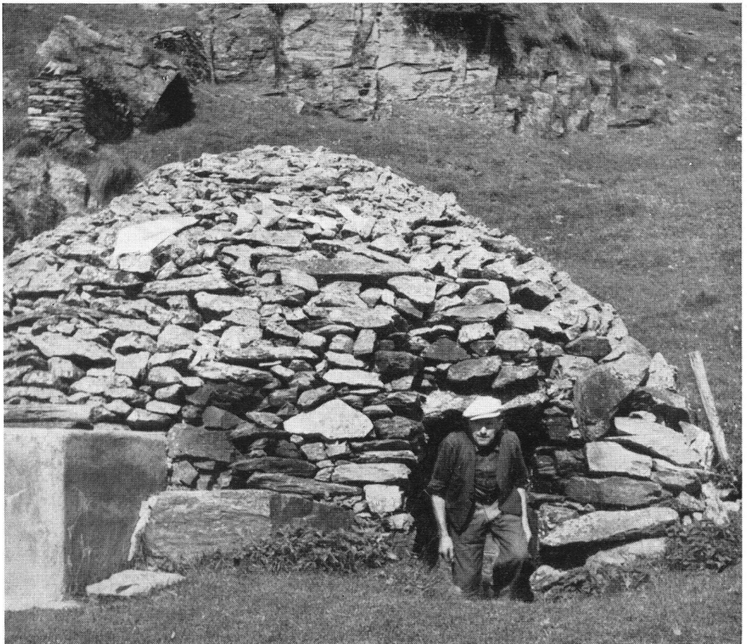
In der Nähe von San Romerio finden wir aber auch noch Beispiele der altertümlichen, aus Trockenmauerwerk ge- wölbten Milchkeller. So dürften die prähistorischen Wohnbauten des Tales ausgesehen haben.
