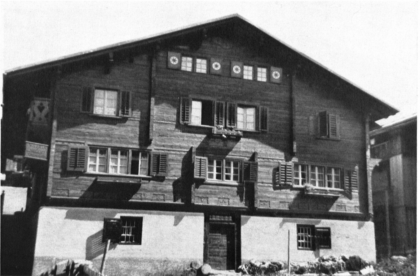
Casa Casaulta, Lumbrin/Lumnezia, erbaut 1828 durch Meister Gion Fidel Casanova. – Restauriert 1947/48 unter Beratung des Bündner Heimatschutzes. Wahl und Ausführung der Schnitzereien geben dem Meister Gion Fidel einen hervorragenden Platz in der großen Reihe der uns bekannten Zimmerleute in der Surselva. Für eines seiner Häuser zahlte damals der Bauberr die Summe von 290 renschs (Rheinische Gulden), auf Franken umgerechnet (1852) zirka 500.
