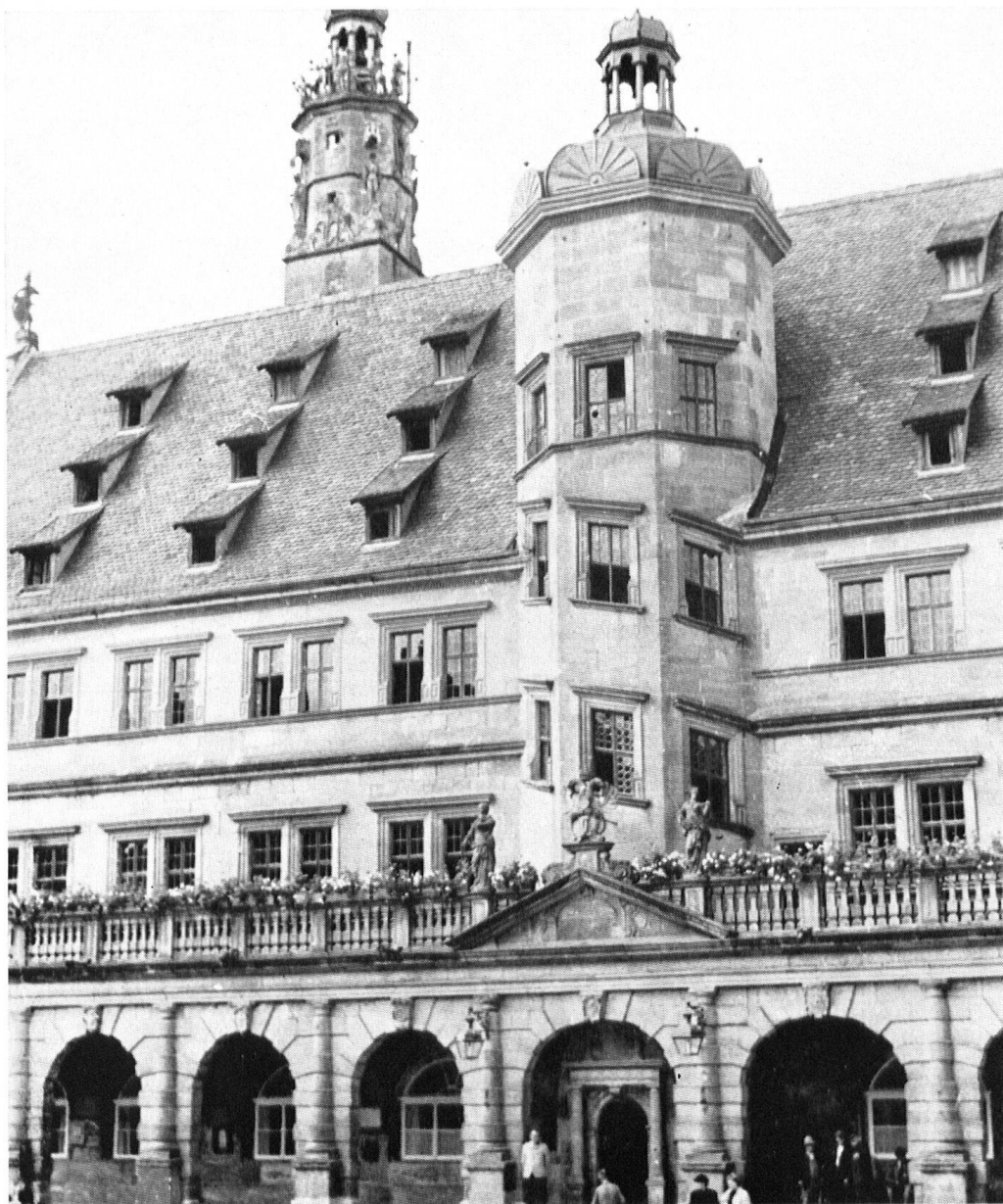
Teilbild des wieder- erstandenen Rathauses. Da alle architektonisch wichtigen Teile erhalten blieben, war es möglich, das Baudenkmal wieder so instand zu stellen, wie es ehedem gewesen ist.
