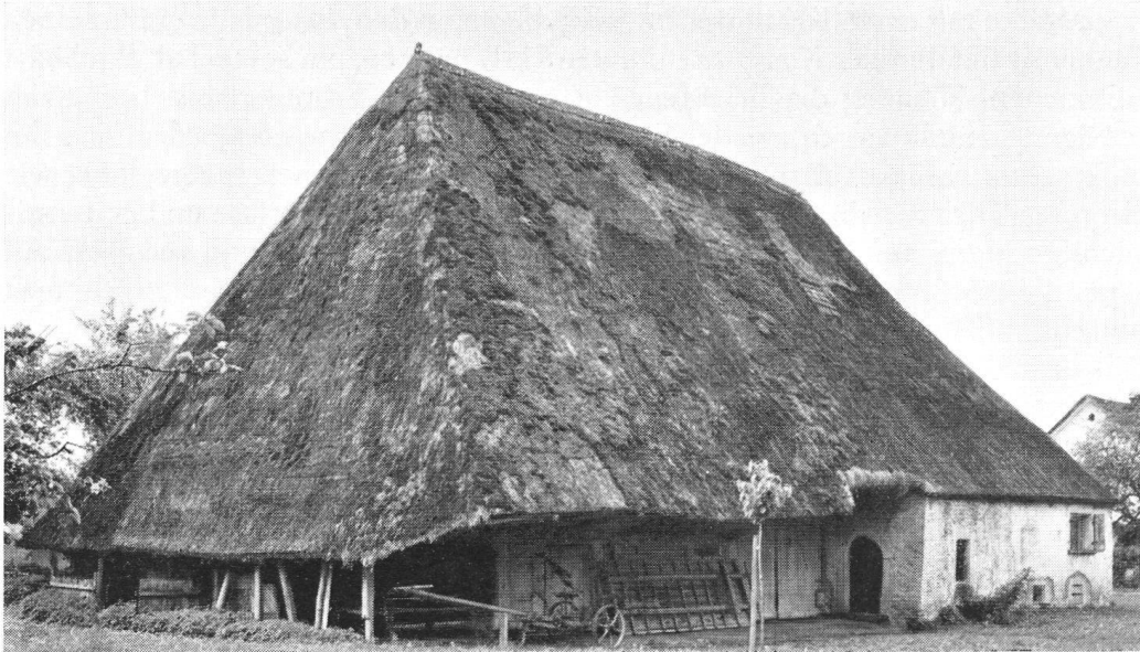
Das Lüscher-Haus in Muhen, das bau- und kulturgeschichtlich wertvollste der wenigen noch verbliebenen Aargauer Stroh Häuser. Hinteransicht mit dem gemauerten Wohnstock der Großeltern.
