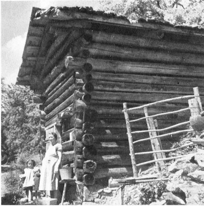
Le musée de plein air comprendra aussi des bâtiments mineurs. Nous présentons ici un « Gaden » (Prätigau GR) dont les parois sont fermées de troncs de sapins écorcés.
