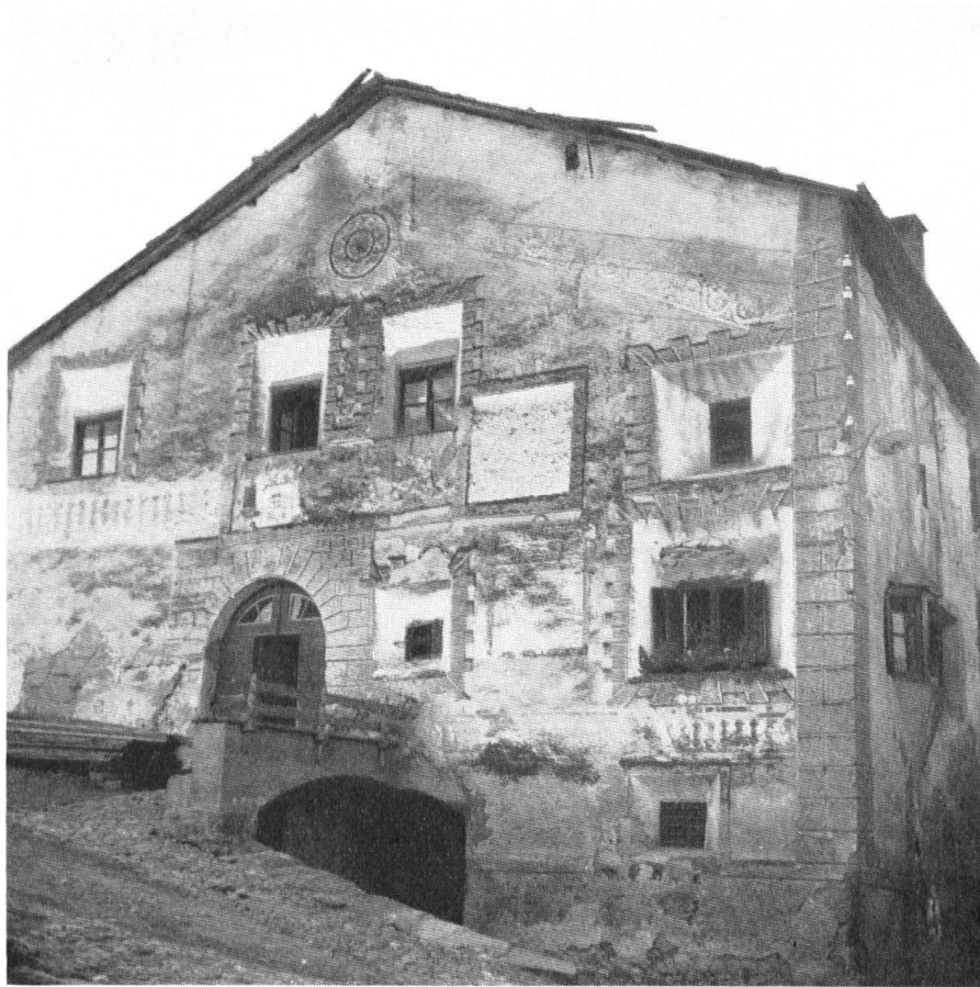
Unmittelbar an der vielbefahrenen Dorfstraße, der Unterengadiner Talstraße, steht in Ardez das Haus Stupan. Wie eine Inschrift verkündet, wurde es anno 1616 (1676?) erstellt. Sein Zustand gab zu schweren Besorgnissen Anlaß.
