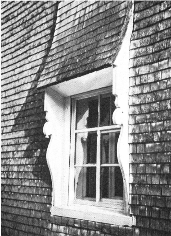
Charakteristischer Schindelschirm mit «Ohrenklappen», in der Regel auf der der Front des Appenzellerhauses entgegengesetzten Seite. Die als Schindelschirm gestaltete Seitenfront eines Hauses.
