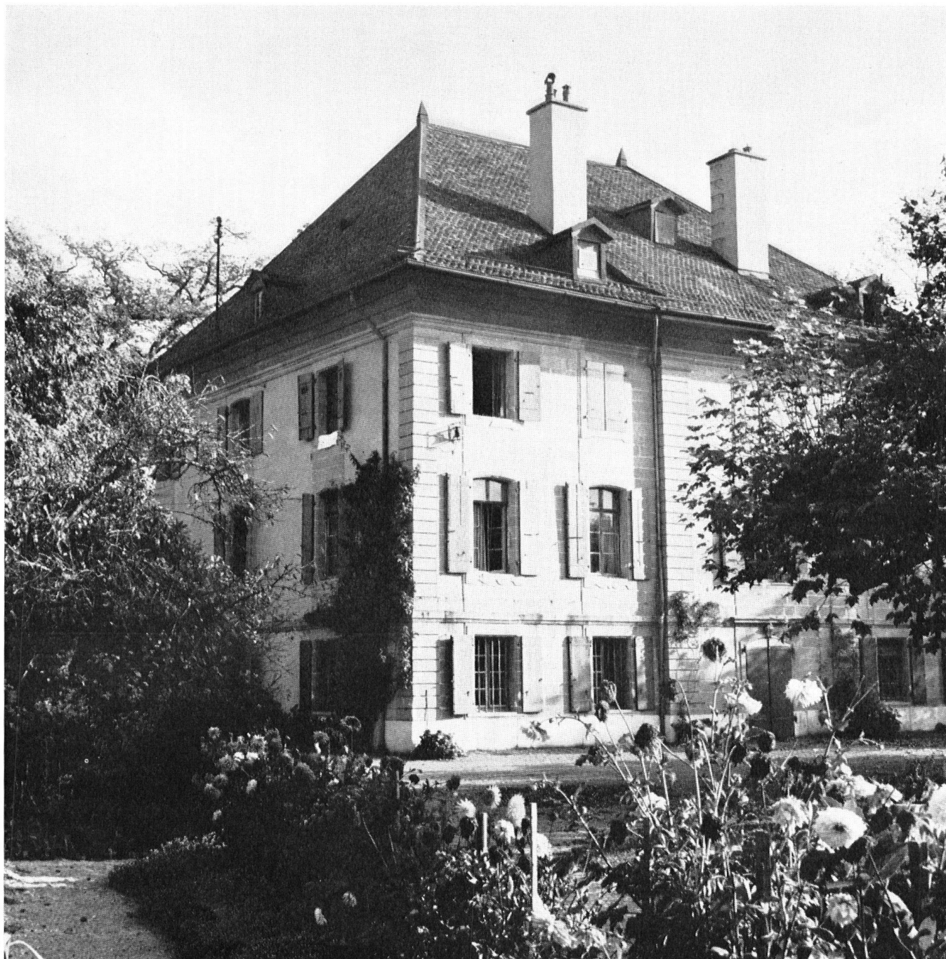
La Grande Pommière, dans la commune de Chêne-Bougeries, mérite également une protection intégrale. Construction massive, surélevée d'un étage à la fin du XVIIIe siècle. Deux chênes gigantesques ombragent la façade d'entrée.
