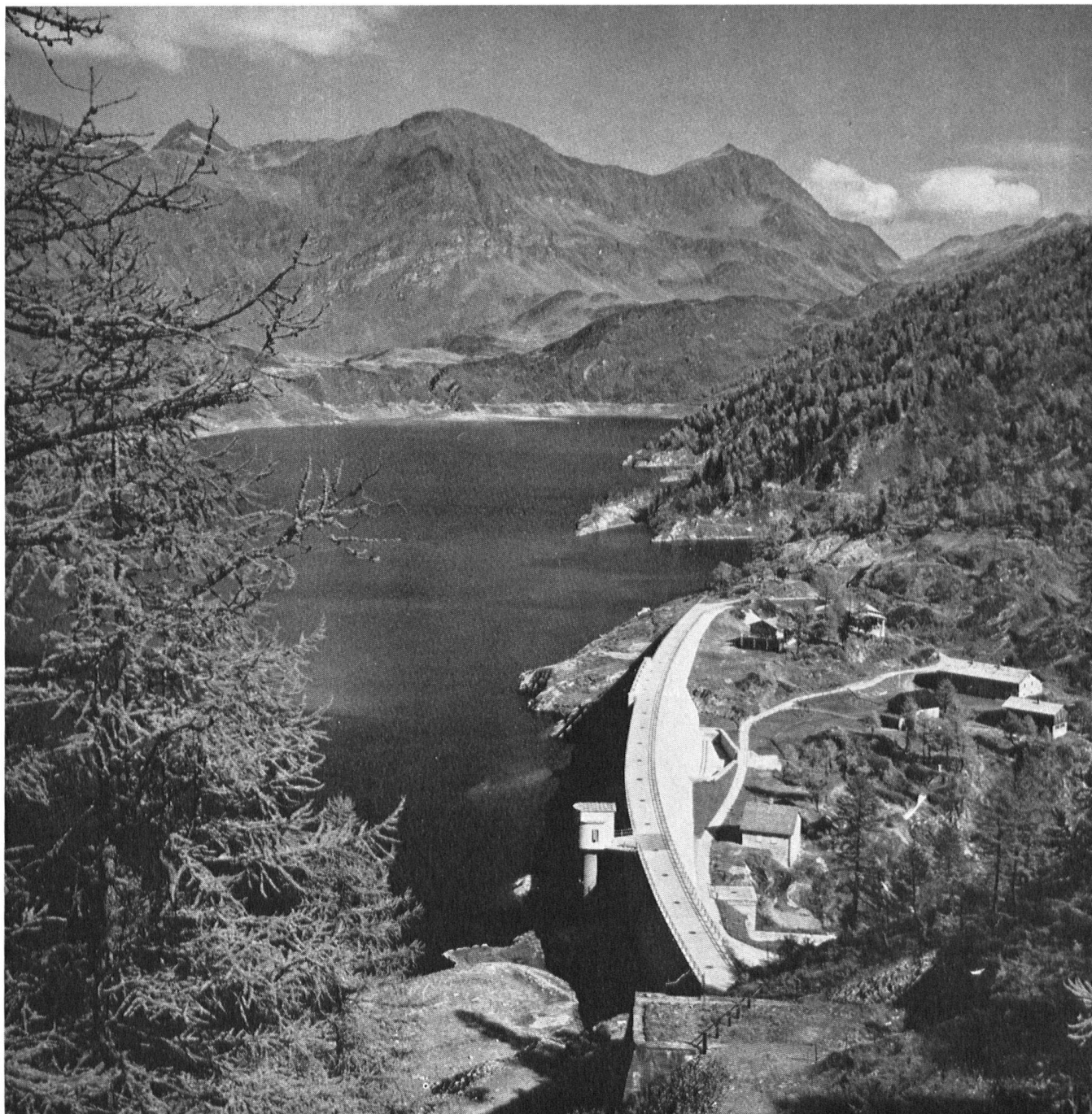
Il y a 50 ans, les C.F.F. firent du lac Ritom, tout au nord du Tessin, un bassin d'accumulation, en surélevant son niveau par un barrage. Vers 1950, seconde surélévation.
