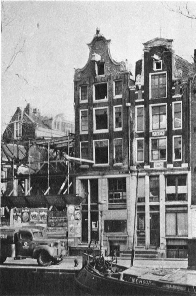
Häuserfronten an der Korte Prinsengracht 5, 7, 9, im Nordwesten der Altstadt. Sie wurden 1965/66 zum Teil restauriert, zum Teil in der authentischen Gestalt von Grund auf neu errichtet.
