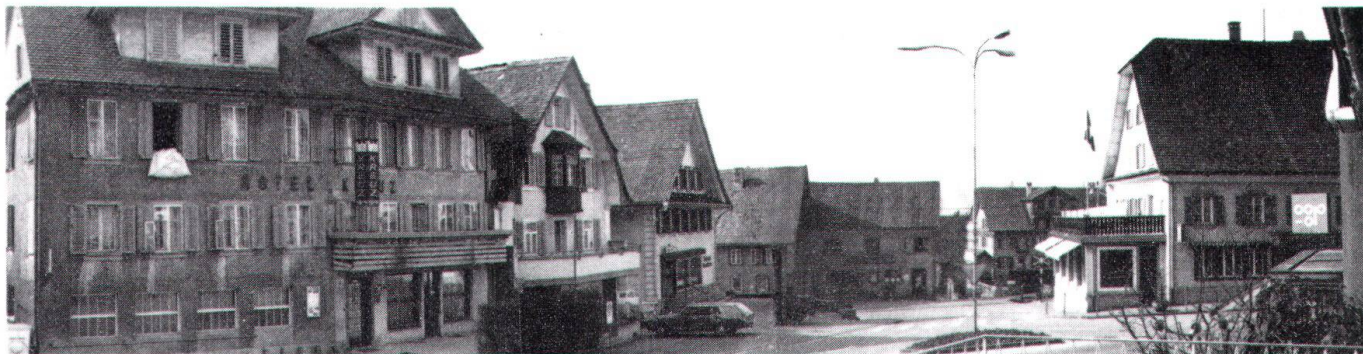
Der untere Dorfeingang von Hochdorf bildet ein harmonisches Ganzes. Durch den Abbruch des Hauses Sticher (drittes von links) würde ein Glied aus der Kette gerissen (Bild Steiner).
