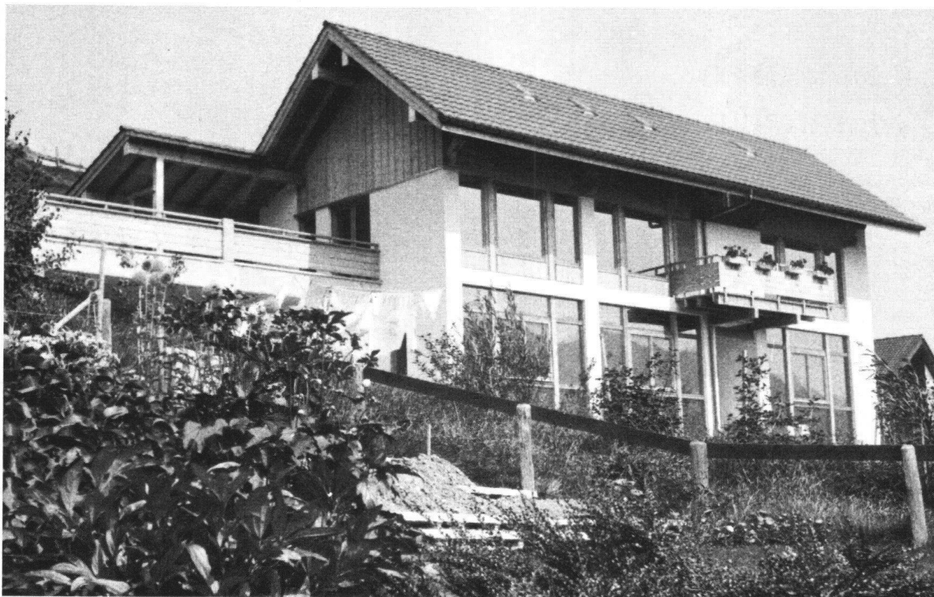
Exemple d'installation solaire parfaitement intégrée, à Gonten AR: dans cette maison familiale, collecteurs et fenêtres rivalisent de clarté avec les façades sud des maisons traditionnelles de l'endroit (photo Schäfer).
