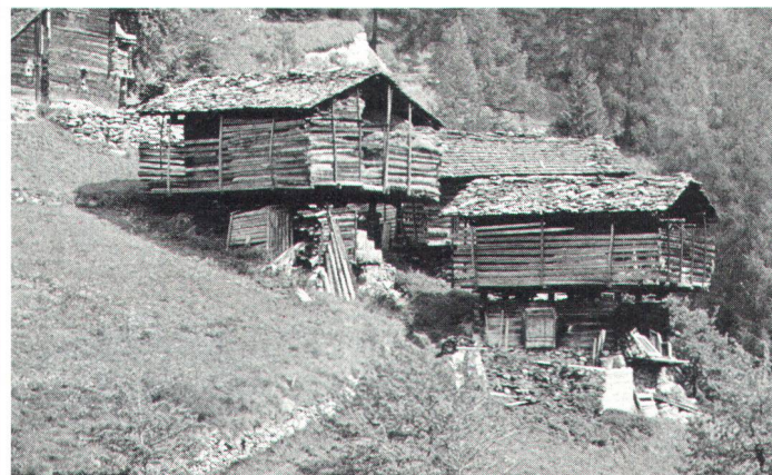
Le raccard abrite les gerbes de céréales. Im Stadel werden die Getreidegarben untergebracht.
