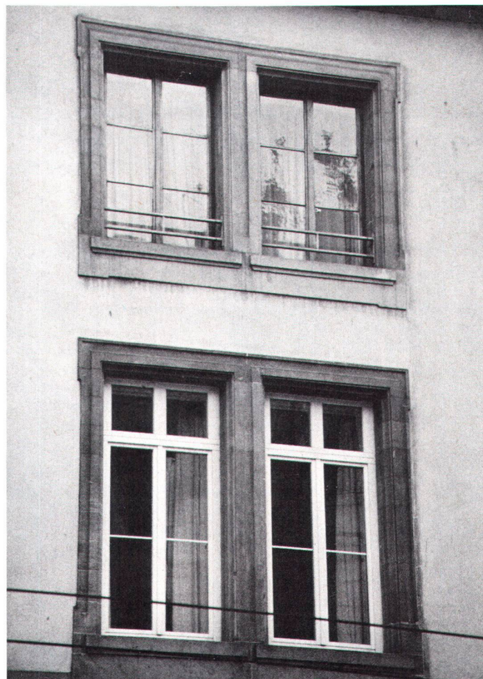
Fenêtres à verre isolant et croisillons factices (en bas); comparer avec l'ancienne fenêtre du haut.
