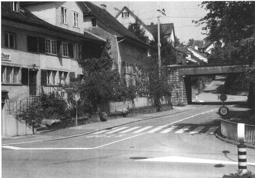
La voie ferrée de la rive droite du lac de Zurich doit être doublée. Cela peut porter atteinte au centre encore intact du village de Zollikon.
