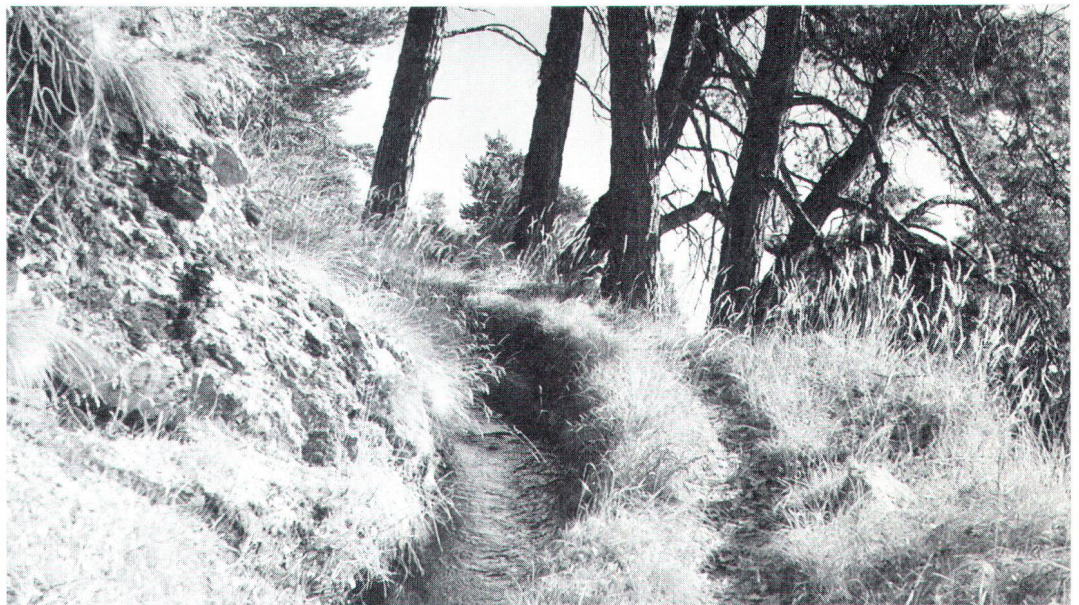
Typiques du val de Baltschieder sont aujourd'hui encore les bisses à flanc de coteau (ici le «Gorperi»). Charakteristisch für das Baltschiederteral sind noch heute die alten Wasserleiten – hier die Gorperi – längs der Talhänge. (Bild Weiss)
