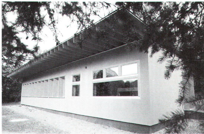
Nicht teurer als eine vorfabrizierte Baracke wurde der Kindergarten von Teodor Biert in Scuol. (Bild AGB-GR)
