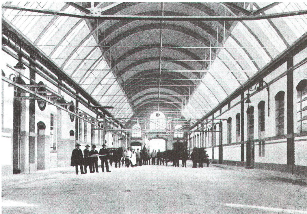
Vue intérieure et historique des abattoirs de La Chaux-de-Fonds. Historische Innenaufnahme der Schlachthalle von La Chaux-de-Fonds.
